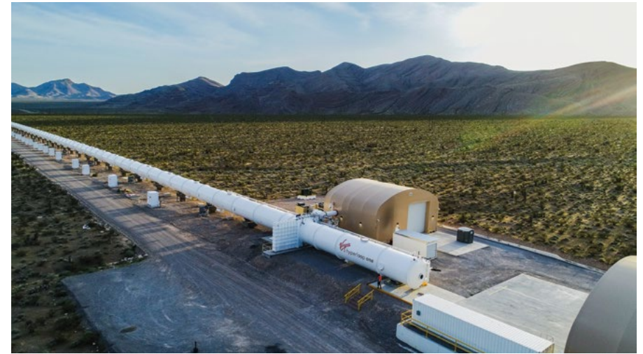
«ديفلوب» سكة اختبار تقنية الهايبرلوب الكاملة الأولى لشركة «فيرجن هايبرلوب ون» شمال لاس فيغاس في ولاية نيفادا
